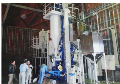
精米機設置工事 2015 年 10 月
